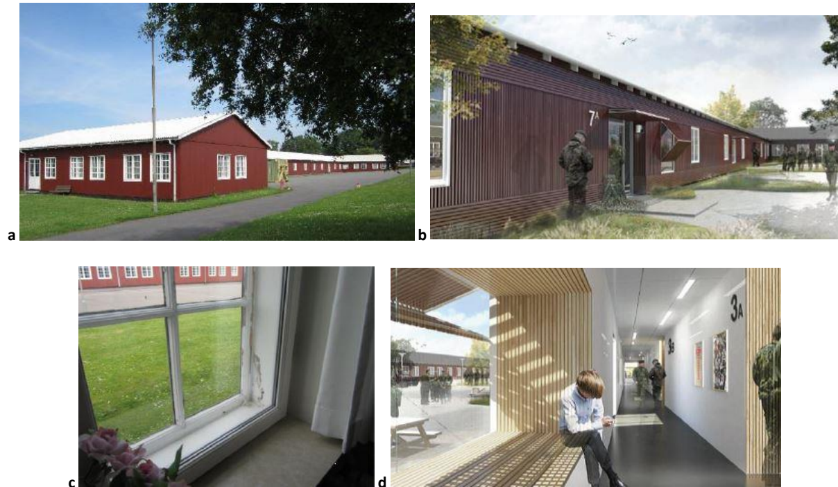
On the left (a & c) before the energy retrofit. On the right (b & d) after retrofit. Source: Grønne Etablissements. Fase II. Almegård Kaserne /19113.Forsvarets Bygnings og Etablissementstjeneste (FBE). March 10, 2014.
